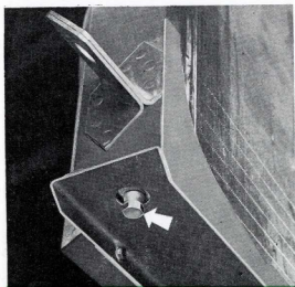
00-39 - VIDANGE DU RADIATEUR CABINE AVANCÉE (VOSGES)
